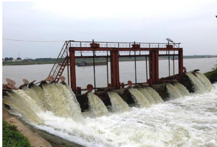
Công trình thủy lợi
